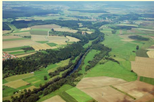
Zustand vor der Sanierung
